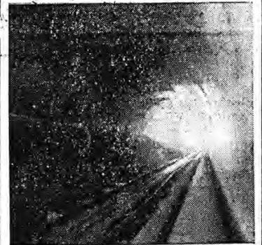
Der Tunnel zum Hillbach während des Baues. Rechts unten die Pressluftleitung für die Bohrmaschinen. Durch das grosse Rohr wird Atemluft zugeführt
